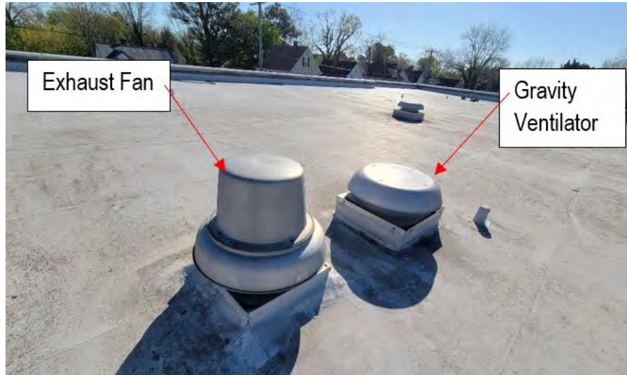
(MP17) Exhaust Fan & Gravity Ventilation
